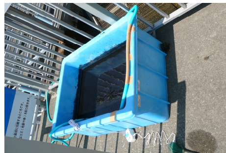
⑥ポンプを設置
