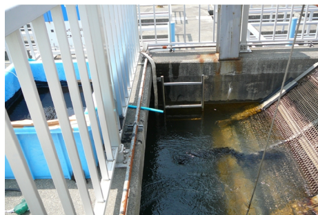
⑧注入状況
