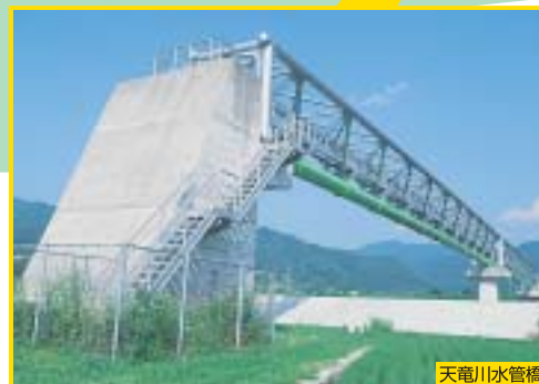
天竜川水管橋
